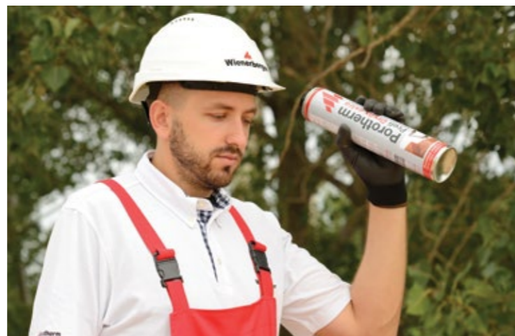
6 Se agită spuma Porotherm Profi Dryfix extra de 20 de ori.
