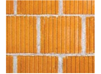
• Blocuri ceramice cu goluri verticale puse în operă cu rost vertical și orizontal de mortar.
