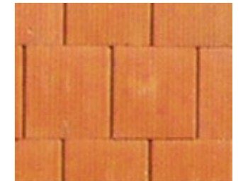
• Blocuri ceramice cu îmbinare N+F puse în operă cu un strat subțire de mortar sau spumă adezivă Porotherm Profi Dryfix extra, în rost orizontal.
