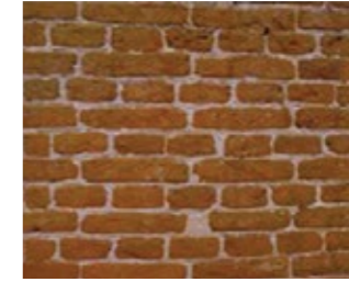
• Cărămizi tradiționale pline puse în operă cu rost vertical și orizontal de mortar
