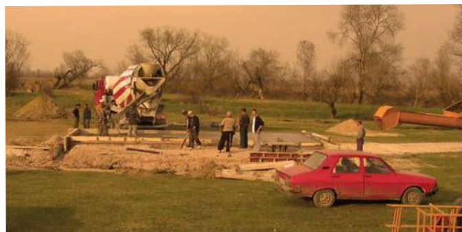
12 aprilie 2006: debutul construcției stației de betoane
