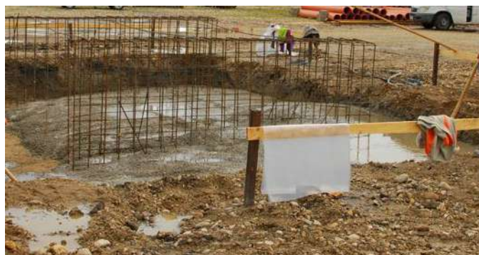
30 martie 2011: lucrări fabrică de asfalt
